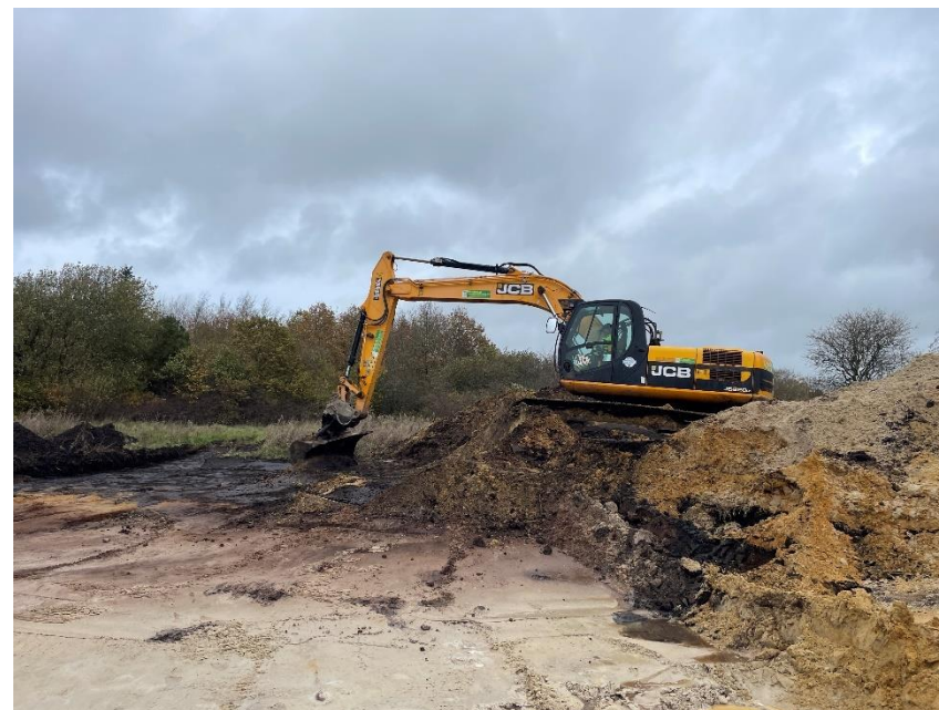
Udgravning af vandhul ved VM-skoven. Foto: Peter Nedergaard Jensen
